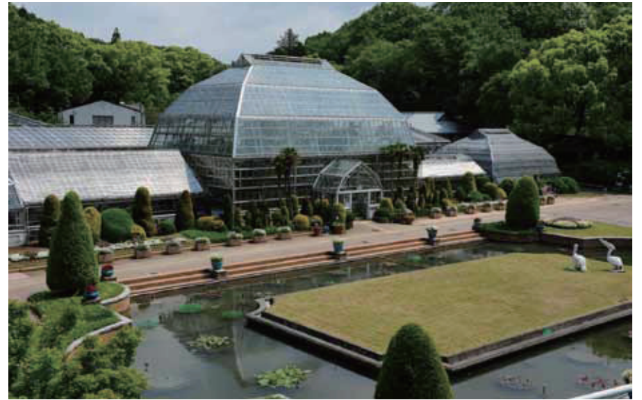
1936年に完成。現存する温室では日本最古の東山植物園温室
