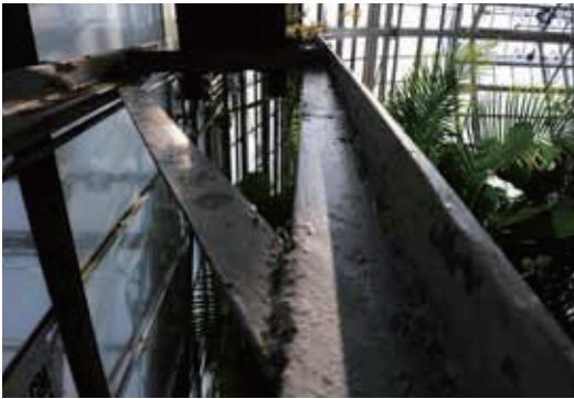
電気溶接で施工された鉄骨造りのアーチを支えられている
